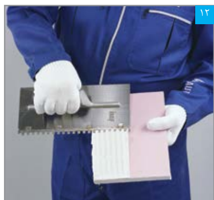
اجرای بتونه درزگیر بر روی نیمی از پنل پشت بند درز (با استفاده از مالیه دندانهدار)
