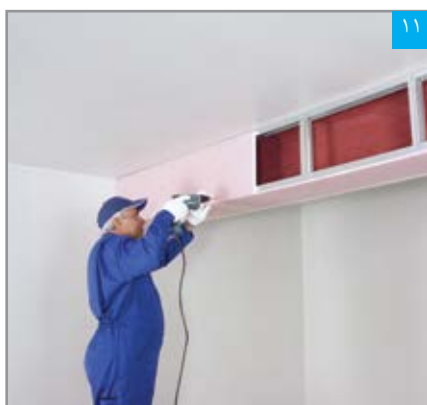
اجرای پنل جانبی
