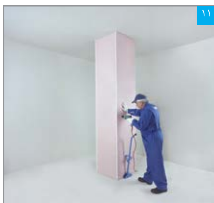
۱۱ تکمیل پوشش کاری لایه دوم
