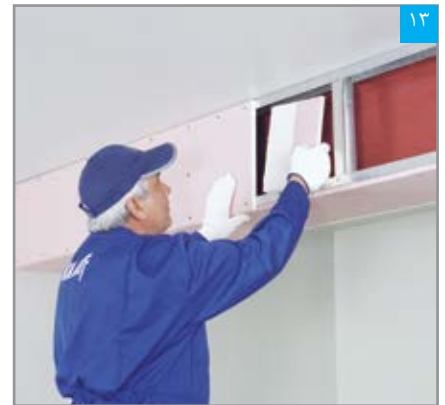
استقرار پنل پشت بند درز
