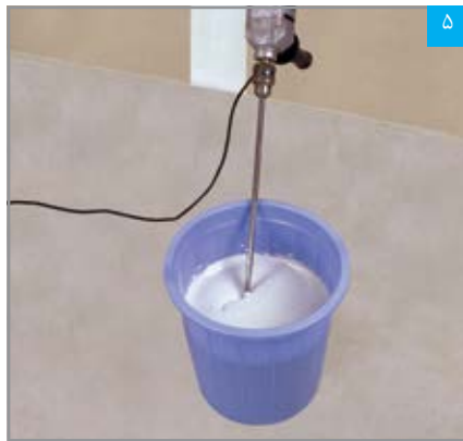
رها کردن خمیر به مدت ۲ تا ۳ دقیقه (مربوط به تهیه ساتن)
