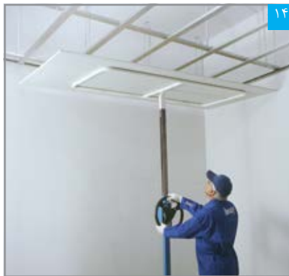
استقرار پنل با استفاده از بالابر
