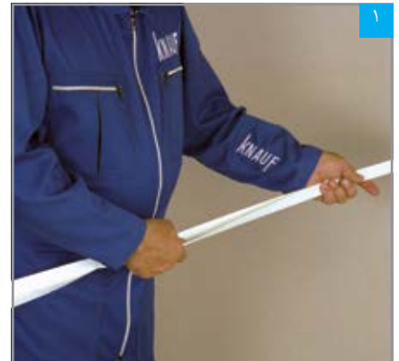
خم کردن نوار درزگیر با دست
