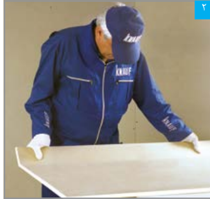
شکستن پنل در محل برش
