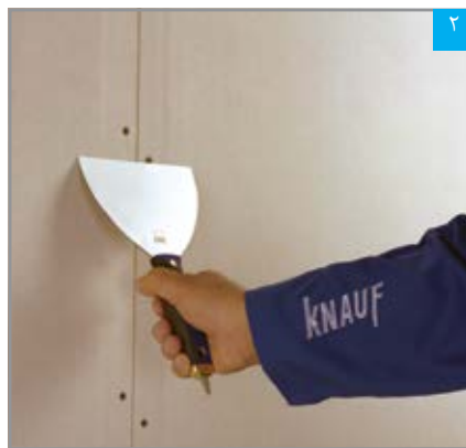
۲ بررسی بیرون زدگی پیچ‌ها با کاردک
