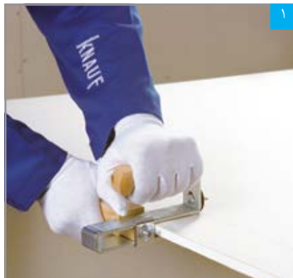
برش پنل با دستگاه برش قرقراهی
