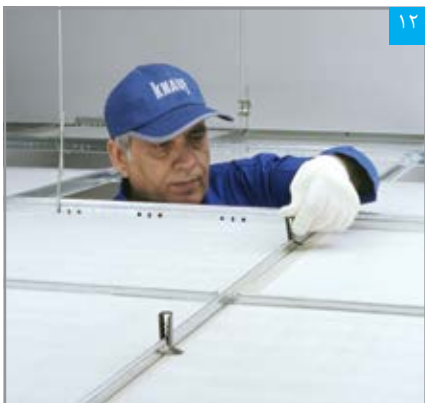
قراردادن گیره‌های مخصوص نگهدارنده تایل
