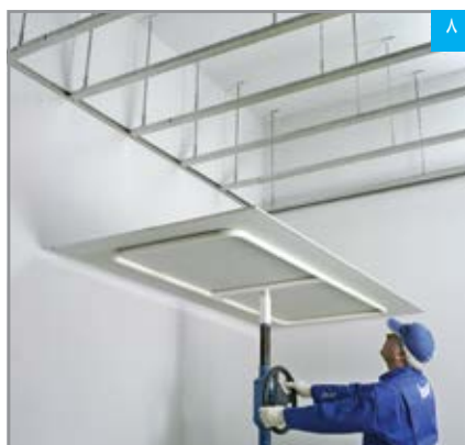
استقرار پنل با استفاده از بالابر
