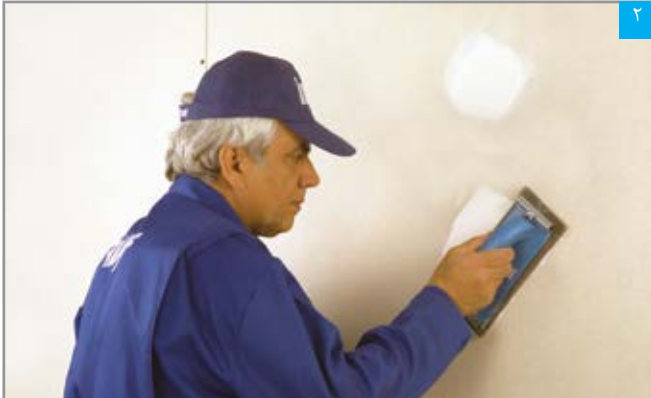
پرداخت سطح بتونه خشک
