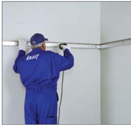
نصب سازه تراز باربر
