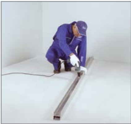
اجرای سازه سقفی دوتایی
