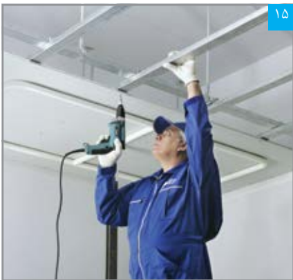
اتصال پنل به زیرسازی توسط پیچ کناف
