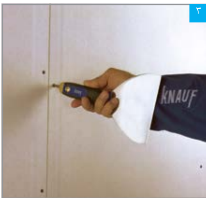
۳ فرو بردن سر پیچ‌ها با پیچ گوشتی پشت کاردک
