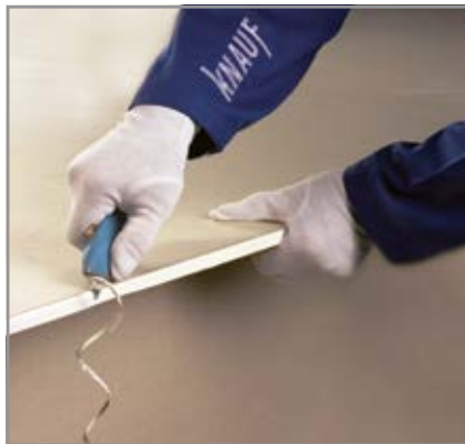
اجرای پخ با تیغ برش
