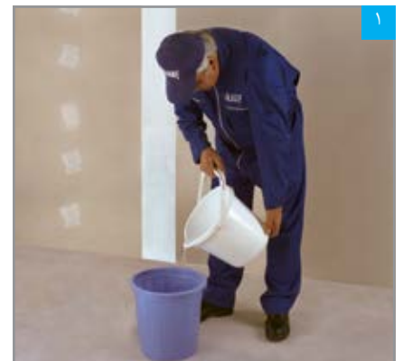
ریختن آب در ظرف مناسب
