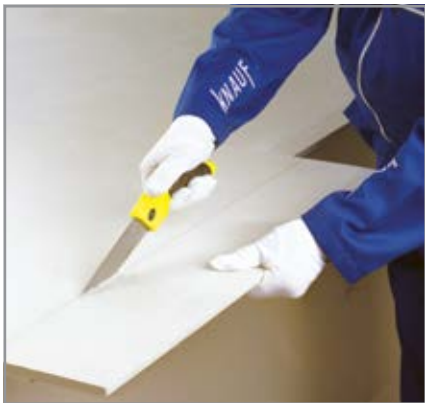
برش پنل با اره دستی
