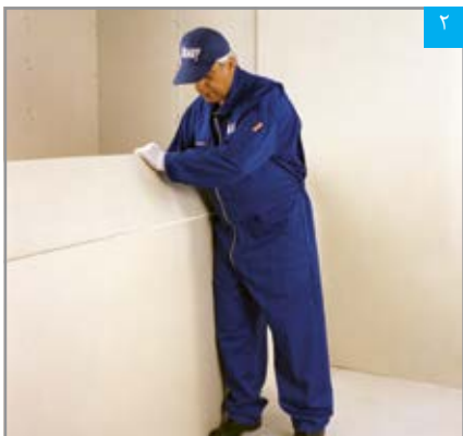
شکستن پنل در محل برش
