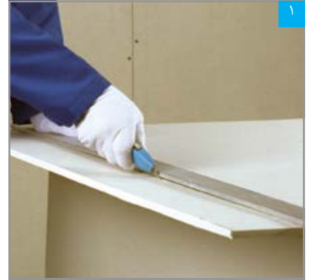
ایجاد شیار (برش کاغذ روکش) بر روی پنل
