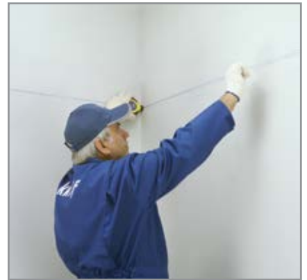
مشخص کردن محل نصب سازه تراز باربر با ریسمان رنگی
