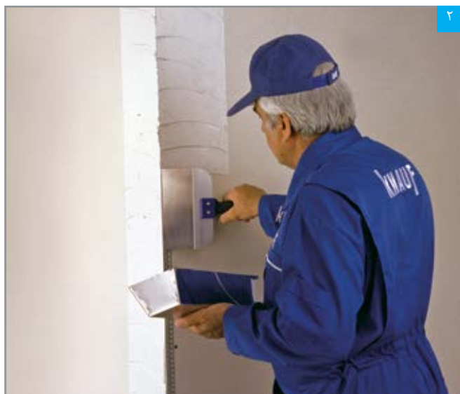
اجرای بتونه روی سازه محافظ گوشه
