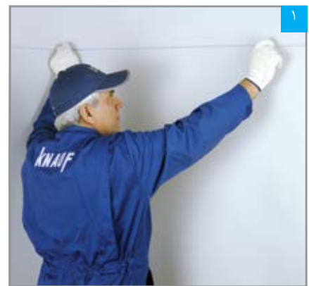
مشخص کردن محل نصب سازه تراز با ریسمان رنگی
