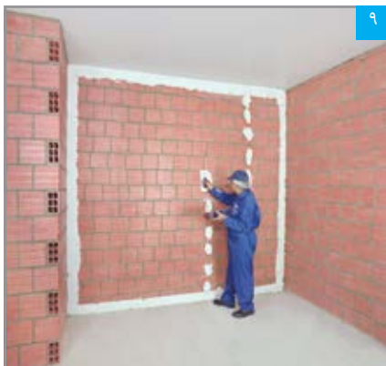
اجرای چانه های پرل‌فیکس بر روی دیوار زمینه (در فواصل مرکز به مرکز حداکثر ۳۵ س.م)
