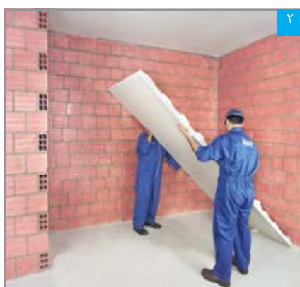
۲ پنل به سادگی توسط دو نفر قابل بلند کردن است
