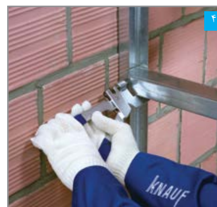
۴ اتصال و تثبیت استاد به رانر (به وسیله پانچ، پرچ یا پیچ)
