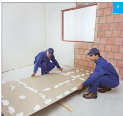
۶ به نحوه اجرای پرفلیکس در محل بازشوی پنجره توجه شود
