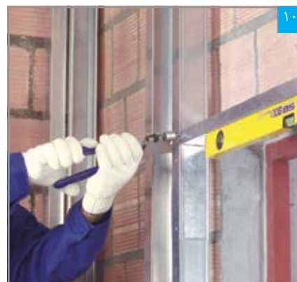
۱۰ اتصال رانر قاب‌بندی فوقانی به استاد به وسیله پانچ، پرچ یا پیچ (به جهت برش ۴۵ درجه توجه شود)
