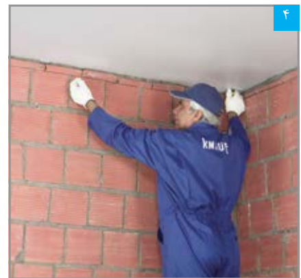
علامت گذاری مسیر لایه پوششی بر روی سقف (با استفاده از ریسمان رنگی)
