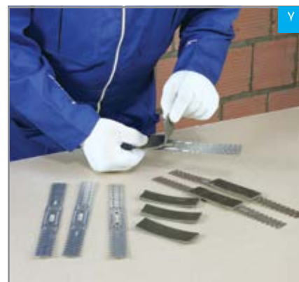
نصب قطعات فوم (عایق) بر پشت براکت‌ها
