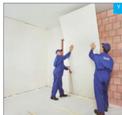
۷ استقرار پنل بر روی دیوار زمینه
