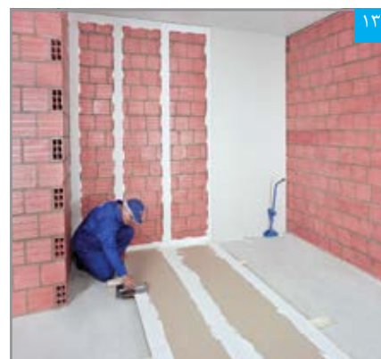
۱۳ لایه نواری بتونه درزگیر را می توان بر پشت پنل ها اجرا نمود
