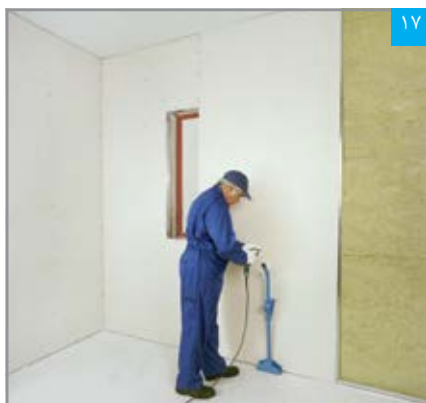
نصب پنل بر روی زیرسازی
