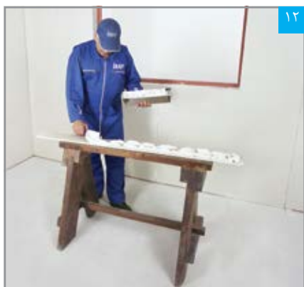
۱۲ اجرای پرفلیکس بر پشت پنل نواری (برای پوشش کاری ناحیه داخلی دور بازشوی پنجره)
