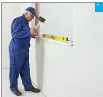
۲۰ نصب و تنظیم سنگ کف پنجره
