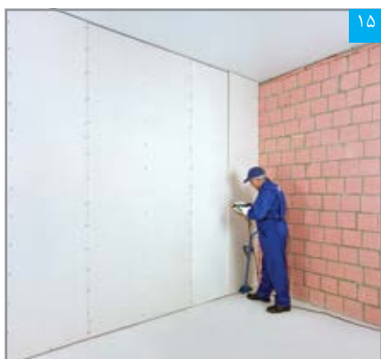
اجرای لایه دوم پنل‌ها؛ ساختار W625.ir (لایه دوم نسبت به لایه اول به صورت حصارچین اجرا می‌شود)
