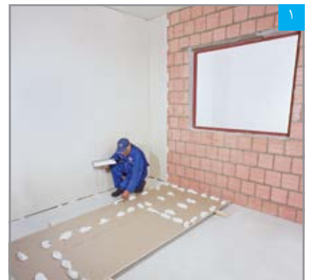
اجرای چانه‌های پرفلیکس بر پشت پنل
