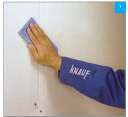
۱ تمیز کردن سطح، قبل از بتونه کاری و یا اجرای ماستیک بسیار مهم است
