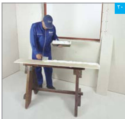
اجرای پرفیکس بر پشت پنل نواری (برای پوشش کاری ناحیه داخلی دور بازشوی پنجره)
