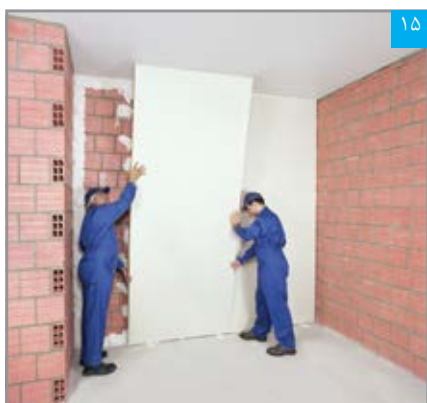
۱۵ پنل‌ها بر روی محور مرکزی ردیف‌های پرفلیکس مستقر می‌شوند
