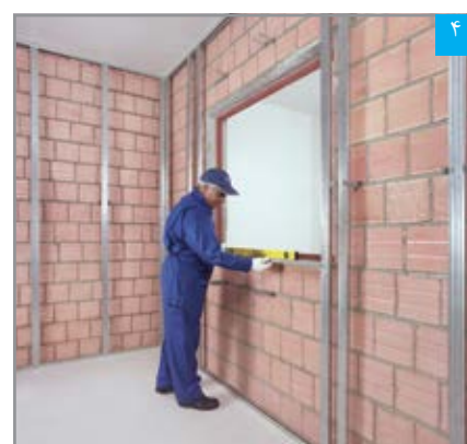
تنظیم سازه قاببندی به وسیله تراز
