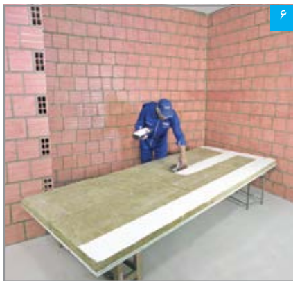
اجرای لایه نواری پرل‌فیکس بر روی لایه پشم معدنی (پشت صفحه مرکب MW)
