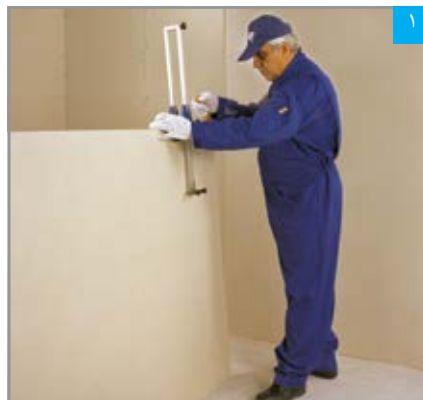
برش پنل با دستگاه برش طولی
