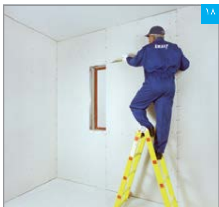
برش پنل به صورت «C» شکل (با استفاده از اره)
