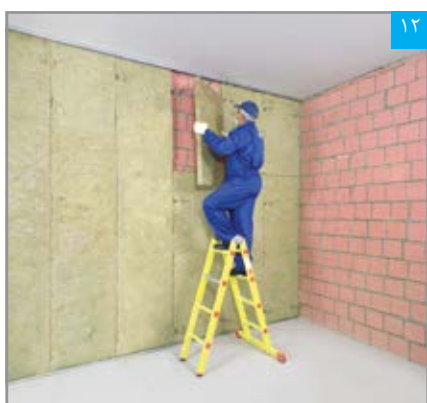
اجرای عایق پشم معدنی
