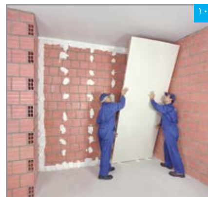
۱۰ پنل به سادگی توسط دو نفر قابل بلند کردن است
