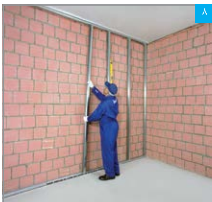
اجرای استاده‌ها (به صورت شاقولی)
