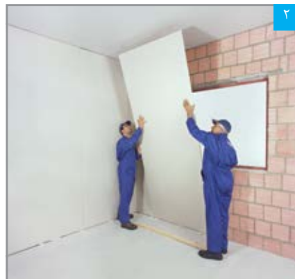
استقرار پنل بر روی دیوار زمینه
