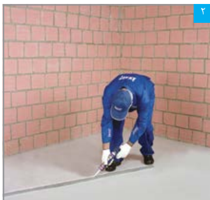
اجرای دو ردیف خمیر درزبند (با نوار عایق) بر پشت سازه‌های هادی کف و سقف
