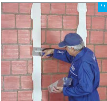
۱۱ اجرای لایه بتونه درزگیر بر روی کرم ها با استفاده از ماله دندانه دار
