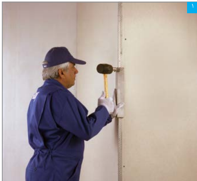
نصب سازه محافظ گوشه با دستگاه کرنربیدکوب
