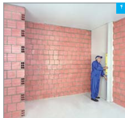
۴ بررسی تراز و تنظیم بودن پنل نصب شده با استفاده از شمشه و تراز
