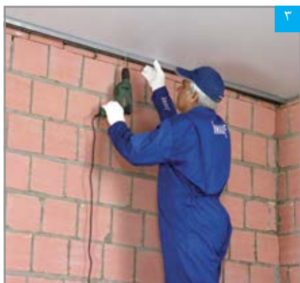
نصب سازه هادی سقف
