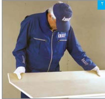
شکستن پنل در محل برش
