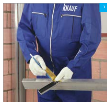
علامت گذاری بر روی رانر قاب‌بندی بازشوی پنجره (به اندازه ۲۰ سانتیمتر و به صورت فارسی بر)
