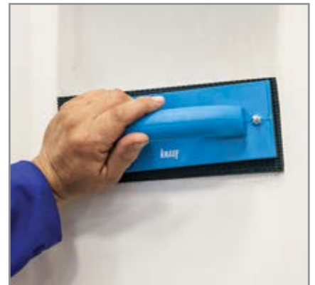
مرطوب کردن سطح دیوار با اسفنج نمدار
