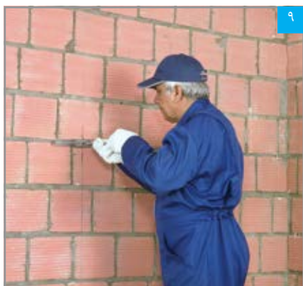
نصب براکت بر روی دیوار زمینه
