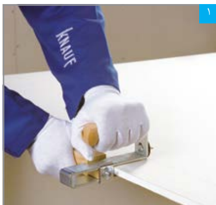
برش پنل با دستگاه برش قرقراهی
