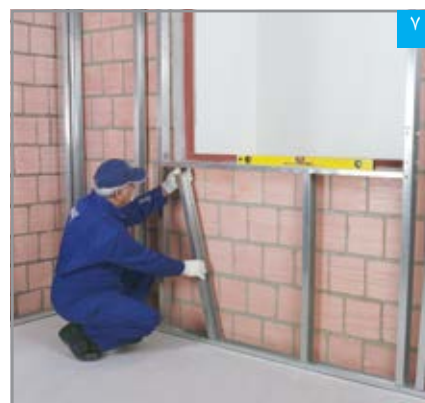
۷ استقرار استاده‌ها در رانر کف و رانر قاب‌بندی تحتانی
