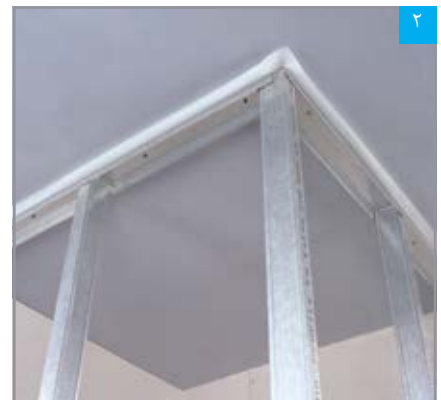
۲ شکستن نوار چسب جداکننده پس از نصب سازه‌ها
