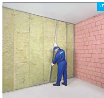
استقرار سازه‌های قائم در سازه‌های هادی و میان براکت‌ها
