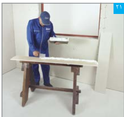
اجرای پرل‌فیکس بر پشت پنل نواری (به اجرای یکپارچه پرل‌فیکس توجه شود)
