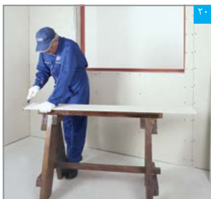
برش پنل نواری (برای پوشش کاری ناحیه داخلی دور بازشوی پنجره)
