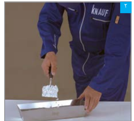
ریختن پودر بتونه در آب
