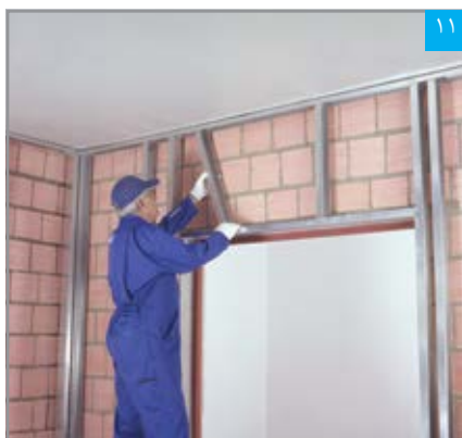
۱۱ استقرار استاده‌ها در رانر سقف و رانر قاب‌بندی فوقانی
