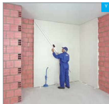
۷ نصب و تنظیم پنل، با پنل نصب شده مجاور
