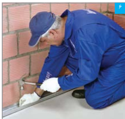
نصب رانر کف
