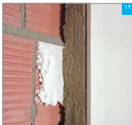
۱۴ ضخامت چانه پرفلیکس پس از نصب و فشردن پنل باید حداقل ۵ میلیمتر باشد
