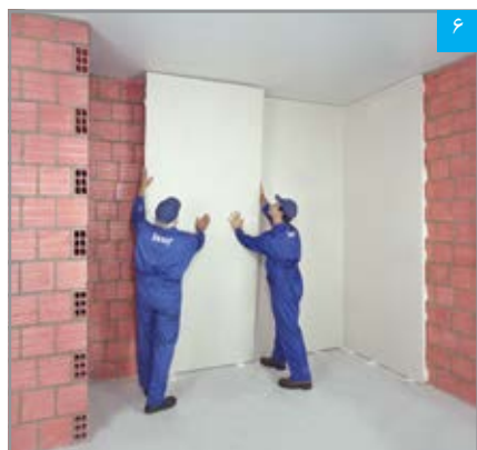
۶ استقرار پنل بر روی دیوار زمینه
