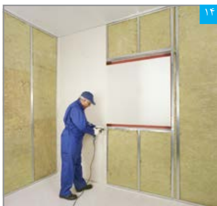
۱۴ نصب پنل بر روی زیرسازی
