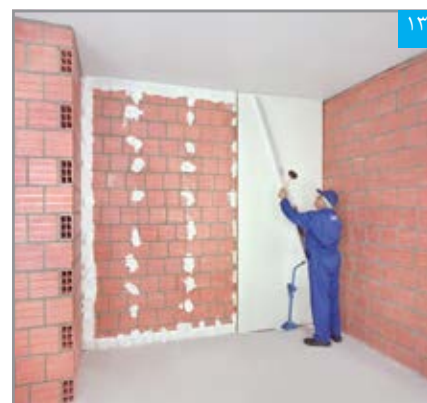
۱۳ تنظیم نهایی پنل نصب شده با شمشه و چکش لاستیکی
