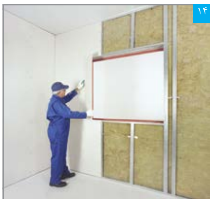
برش پنل با استفاده از تیغ برش
