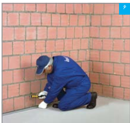
نصب سازه هادی کف
