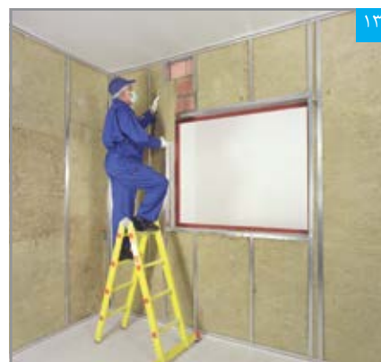
۱۳ اجرای عایق پشم معدنی
