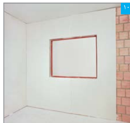
۱۰ پوشش کاری تکمیل شده در ناحیه بیرونی بازشوی پنجره
