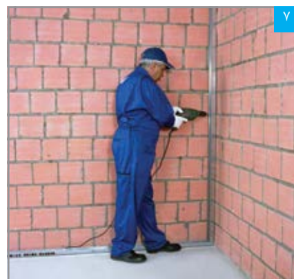
نصب اولین استاد بر روی ساختار جانبی
