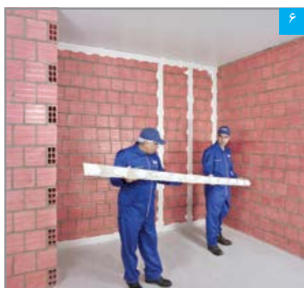
چانه‌های پرفلیکس در فواصل حداکثر ۳۵ سانتیمتر (مرکز به مرکز) بر پشت کرم ها قرار می‌گیرند
