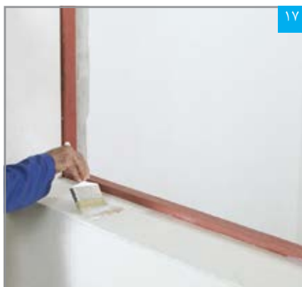
۱۷ اجرای پرایمر بر روی سطح پنل
