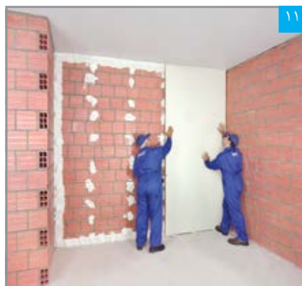
۱۱ استقرار پنل بر روی دیوار زمینه
