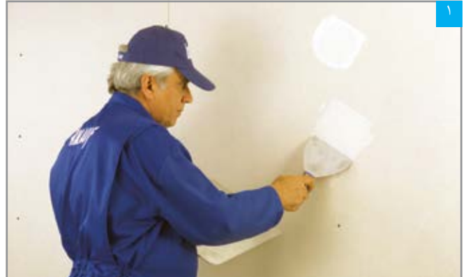
اجرای بتونه در محل پیچ‌ها
