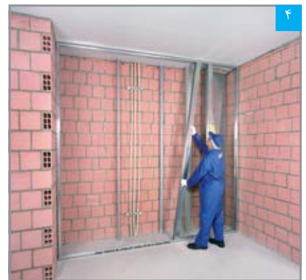
استقرار استادهای دوتایی در رانرها (به صورت شاقولی)
