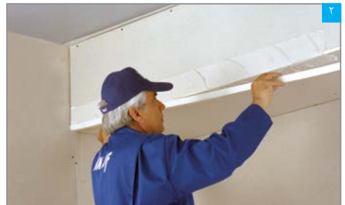
قرار دادن نوار درزگیر بر روی بتونه
