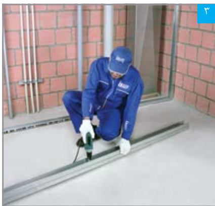
اجرای استادهای دوتایی
