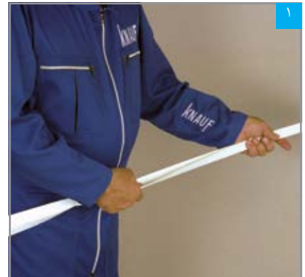
۱ خم کردن نوار درزگیر با دست
