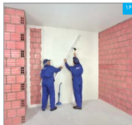
۱۶ نصب و تنظیم پنل، با پنل نصب شده مجاور
