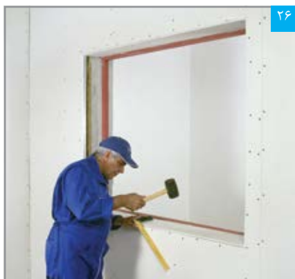
تنظیم پنل نواری (گونیا کردن)
