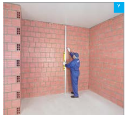
مشخص کردن محل اجرای چانه های پرل‌فیکس بر روی دیوار زمینه
