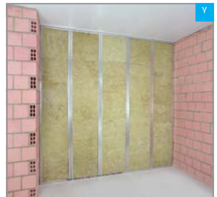
لایه عایق تکمیل شده
