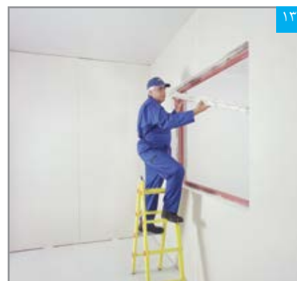
۱۳ استقرار پنل نواری در ناحیه داخلی دور بازشوی پنجره
