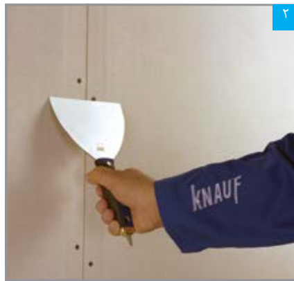
۲ بررسی بیرون زدگی پیچ‌ها با کاردک
