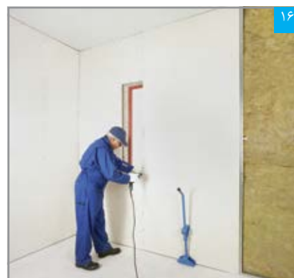
نصب پنل بر روی زیرسازی
