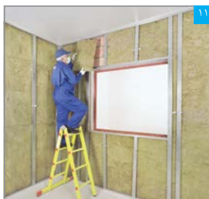
اجرای عایق پشم معدنی
