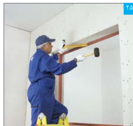
تنظیم پنل نواری (گونیا کردن)
