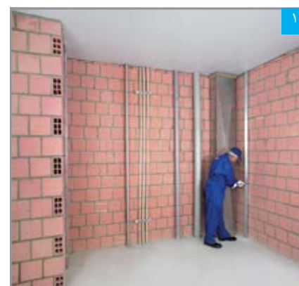
۱ نصب اولین رانر بر روی ساختار جانبی
