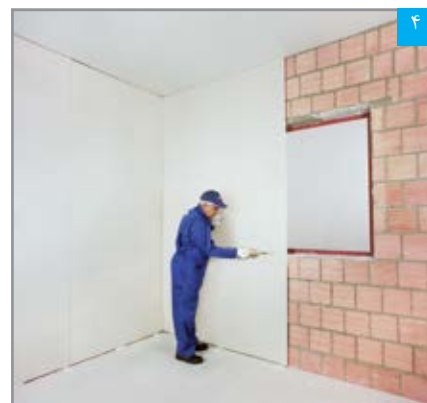
۴ برش پنل با استفاده از اره
