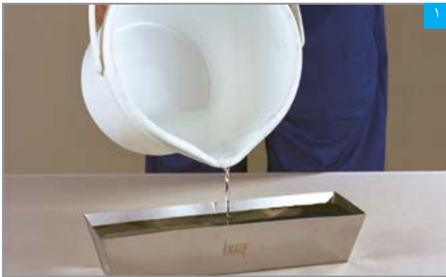
ریختن آب در ظرف تهیه بتونه
