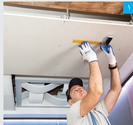
۱ تعیین محل نصب دریچه و ترسیم ابعاد روی پنل
