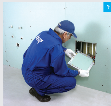
قرار دادن پنل دریچه در درون قاب
