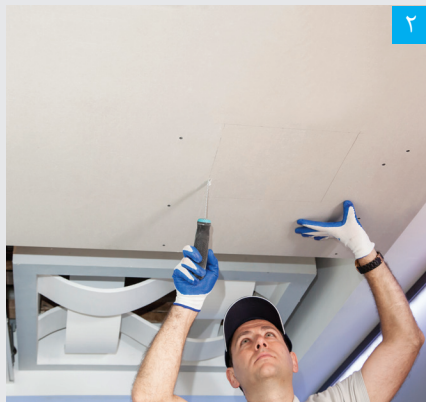
۲ برش کاری محل نصب دریچه ( جهت سهولت نصب هر وجه ۵ میلی متر برش داده شود)
