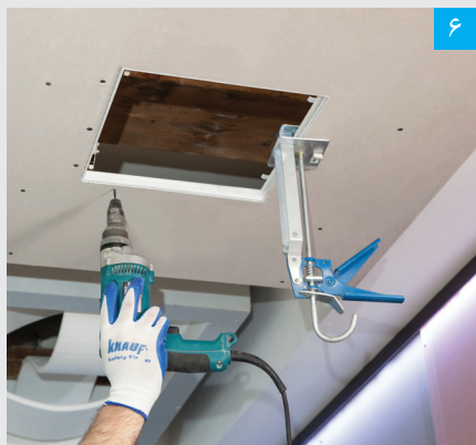
۶ ثابت کردن قاب توسط پیچ به فواصل هر ۱۵ سانتی متر
