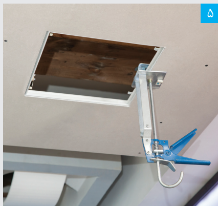
۵ تنظیم و ثابت کردن محل نصب دریچه
