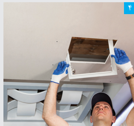
۴ قرارگیری قاب پیرامونی دریچه
