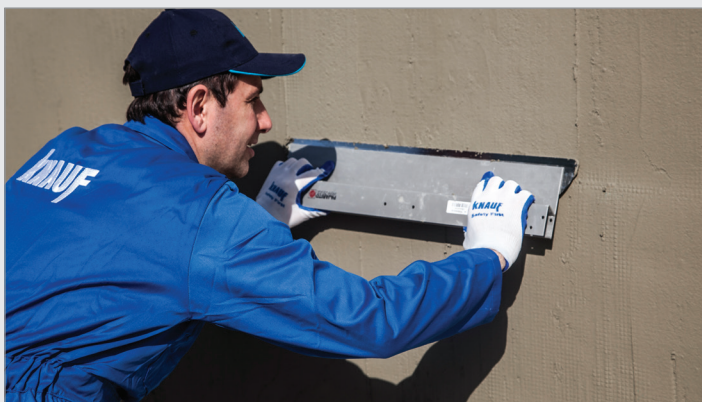
اجرای اندود SM700
