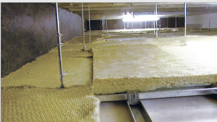
عایق کاری پیلوت
