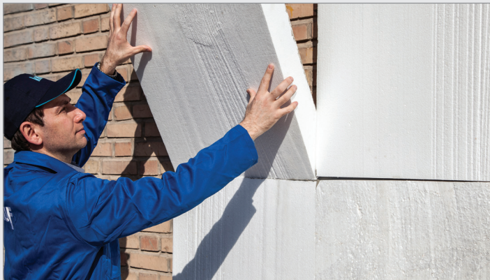
نصب قطعات عایق بر روی دیوار زمینه
