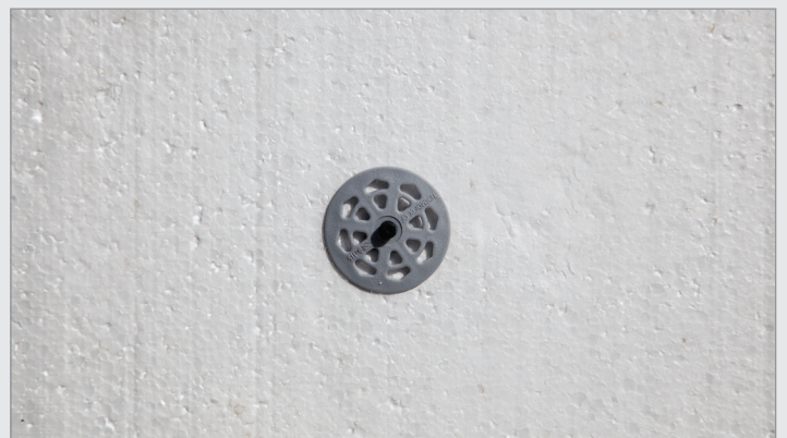
نصب بست‌های Termofix
