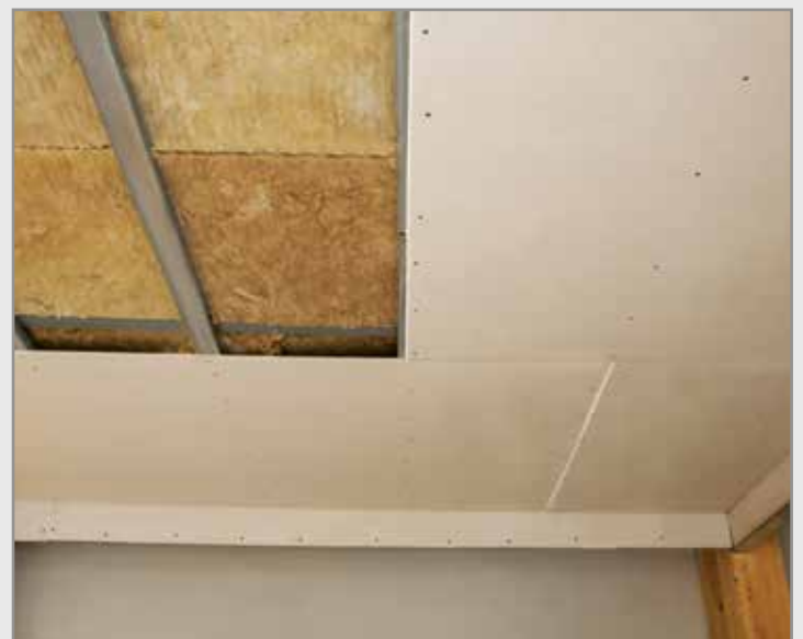
عایق کاری صوتی سقف ساختمان با سقف کاذب کناف
