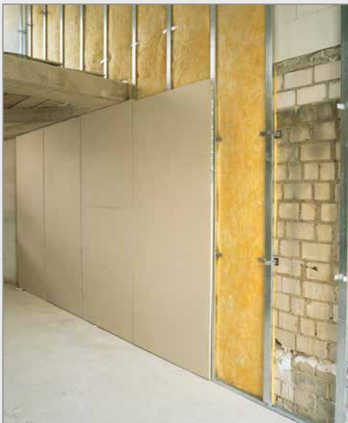
عایق کاری صوتی جدار ساختمان با دیوار پوششی کناف
