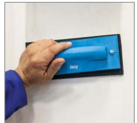
مرطوب کردن سطح دیوار با اسفنج نمدار
