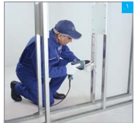
اتصال قطعات نبشی L25 به استادهای مجاور
