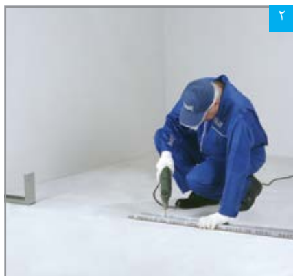
نصب رانر کف
