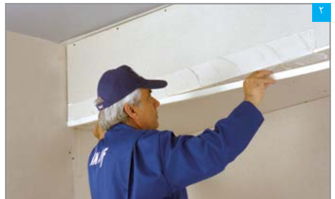
قرار دادن نوار درزگیر بر روی بتونه
