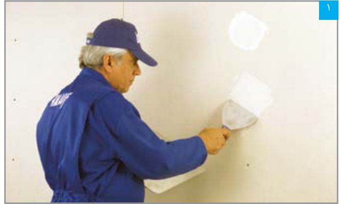
اجرای بتونه در محل پیچ‌ها
