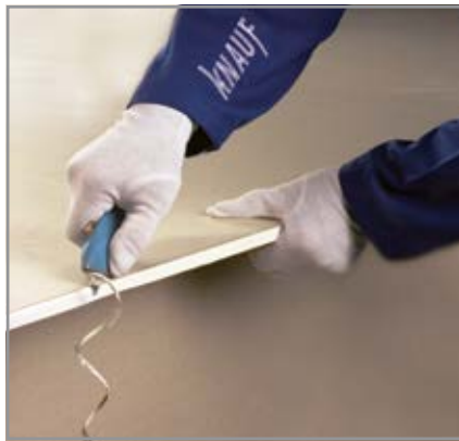
اجرای پخ با تیغ برش
