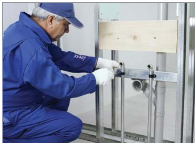
اتصال لوله‌های تاسیساتی به سازه پشتیبان SP60
