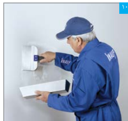
بتونه کاری درزها در محل ترمیم (با استفاده از نوار و بتونه درزگیر کناف)
