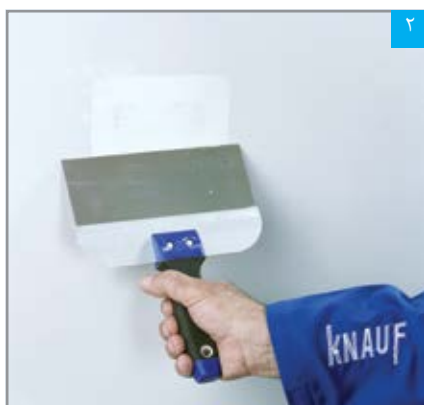
اجرای بتونه بر روی وصله ترمیمی
