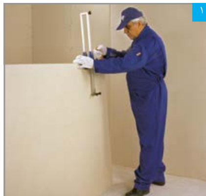
برش پنل با دستگاه برش طولی
