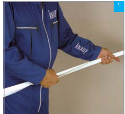
۱ خم کردن نوار درزگیر با دست
