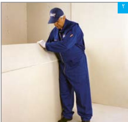
شکستن پنل در محل برش
