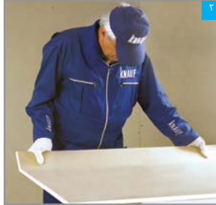
شکستن پنل در محل برش
