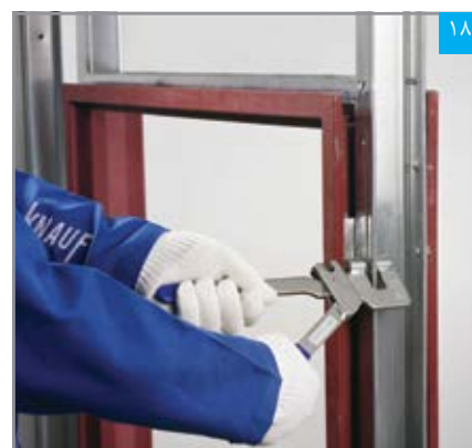
اتصال رانر نعل درگاه به استاداها با پانچ
