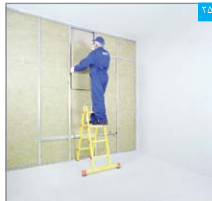
اجرای عایق پشم معدنی در فواصل بین استاداها (توجه شود که تاسیسات در مرحله قبل اجرا شده است)
