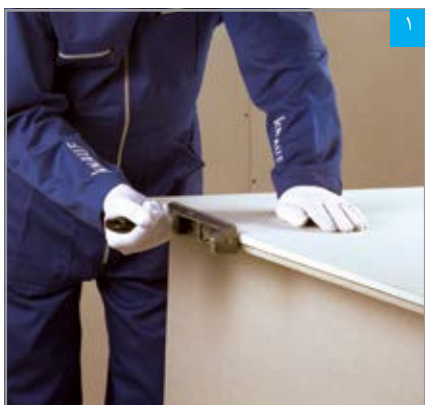
پرداخت لبه برش خورده با رنده
