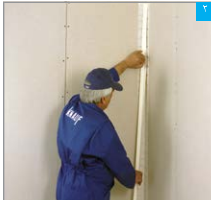
۲ قرار دادن نوار درزگیر بر روی بتونه
