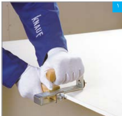
برش پنل با دستگاه برش قرقراهی
