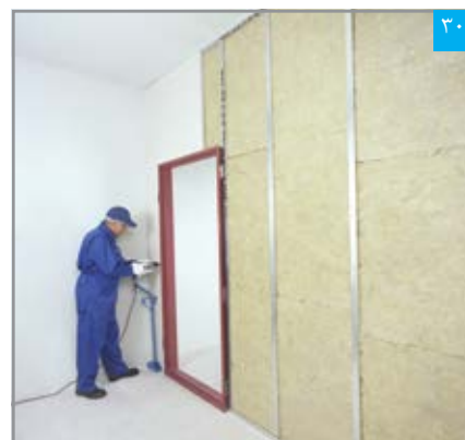
پیچ زنی پنل در حاشیه دور چهارچوب
