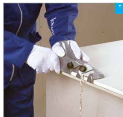
اجرای پخ با پخ زن
