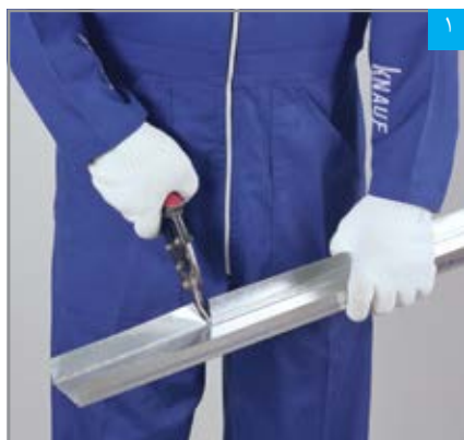
برش انتهای رانرهای کف (در محل بازشوی در) به اندازه ۲۰ سانتیمتر
