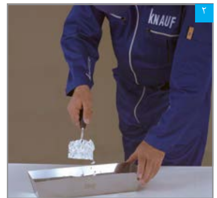
ریختن پودر بتونه در آب
