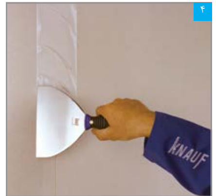
۴ مرحله اول درزگیری: اجرای لایه بتونه در محل درز (کاردک در جهت عمود بر درز کشیده می‌شود تا بتونه کاملاً در درز نفوذ کند)
