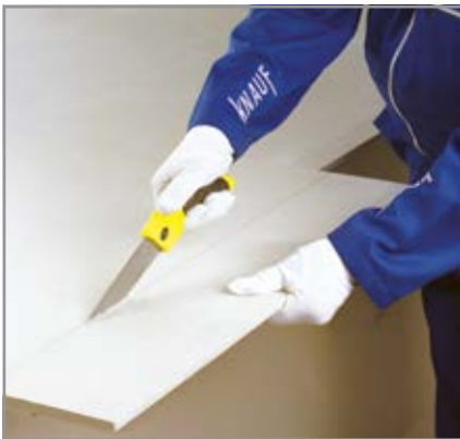
برش پنل با اره دستی
