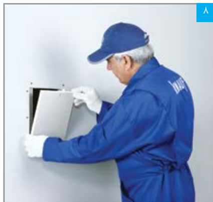
۸ قرار دادن قطعه پنل جایگزین در محل خود
