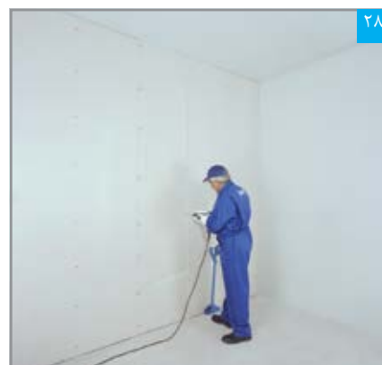
اجرای لایه دوم پنل‌ها؛ ساختار W112.ir (لایه دوم نسبت به لایه اول به صورت حصیرچین اجرا می‌شود)
