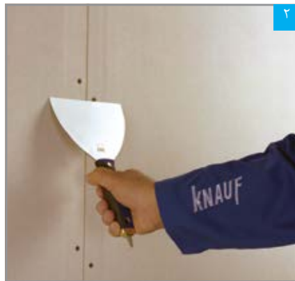
۲ بررسی بیرون زدگی پیچ‌ها با کاردک
