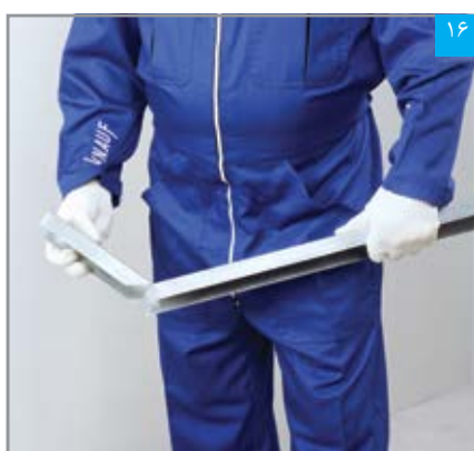
خم کردن انتهای رانر نعل درگاه
