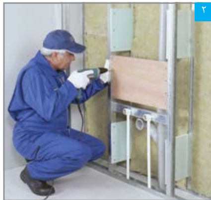
اتصال تراورس (تخته چند لایه) به قطعات نبشی L25
