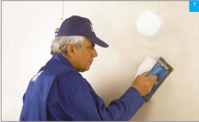
پرداخت سطح بتونه خشک
