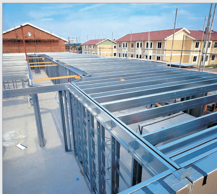
شکل ۲۹: سیستم سازه فولادی سبک (LSF)
