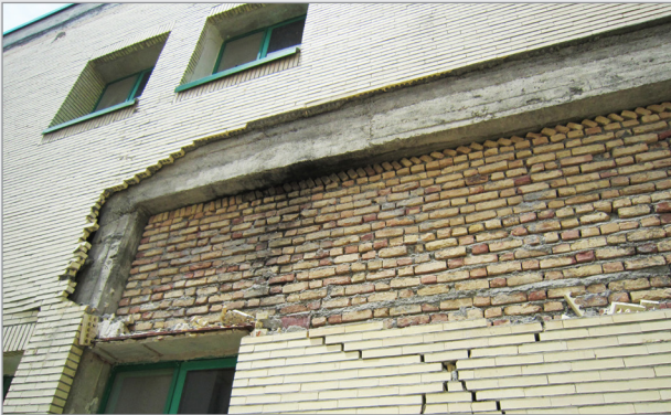
شکل ۱۳: ریزش قطعات آجر نما
