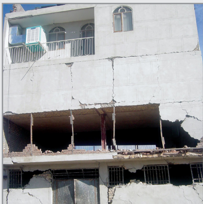
شکل ۳: انهدام خارج از صفحه دیوارهای بنایی
