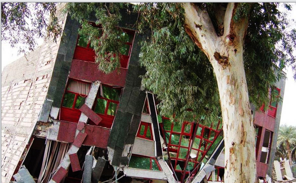
شکل ۱۴: ریزش قطعات سنگ پلاک
