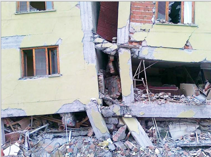
شکل ۷: تخریب ساختمان در اثر طبقه نرم زیرین
