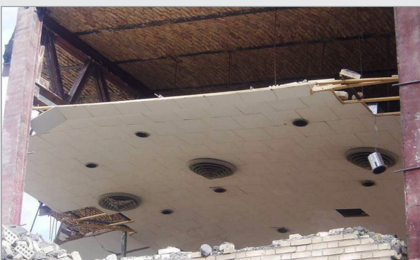
شکل ۱۵: اجرای سقف‌های کاذب با روش سنتی
