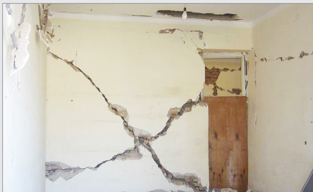
شکل ۱۲: شکست انفجاری دیوار بنایی
