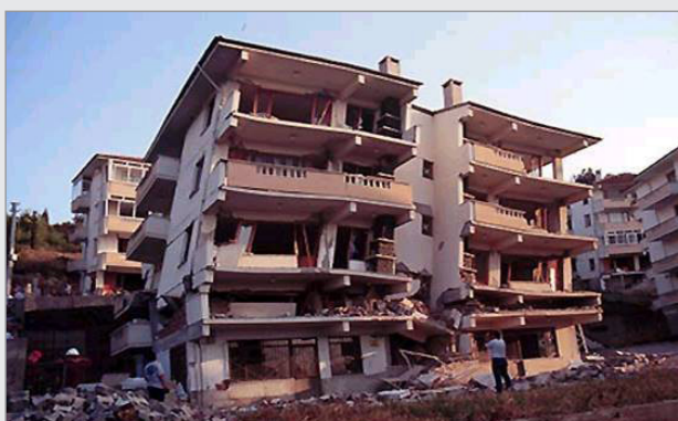
شکل ۱۰: تخریب در اثر حرکت پیشی ساختمان
