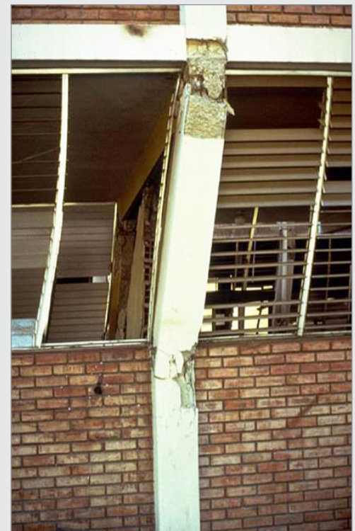
شکل ۸: شکست ترد برشی در ستون بتنی
